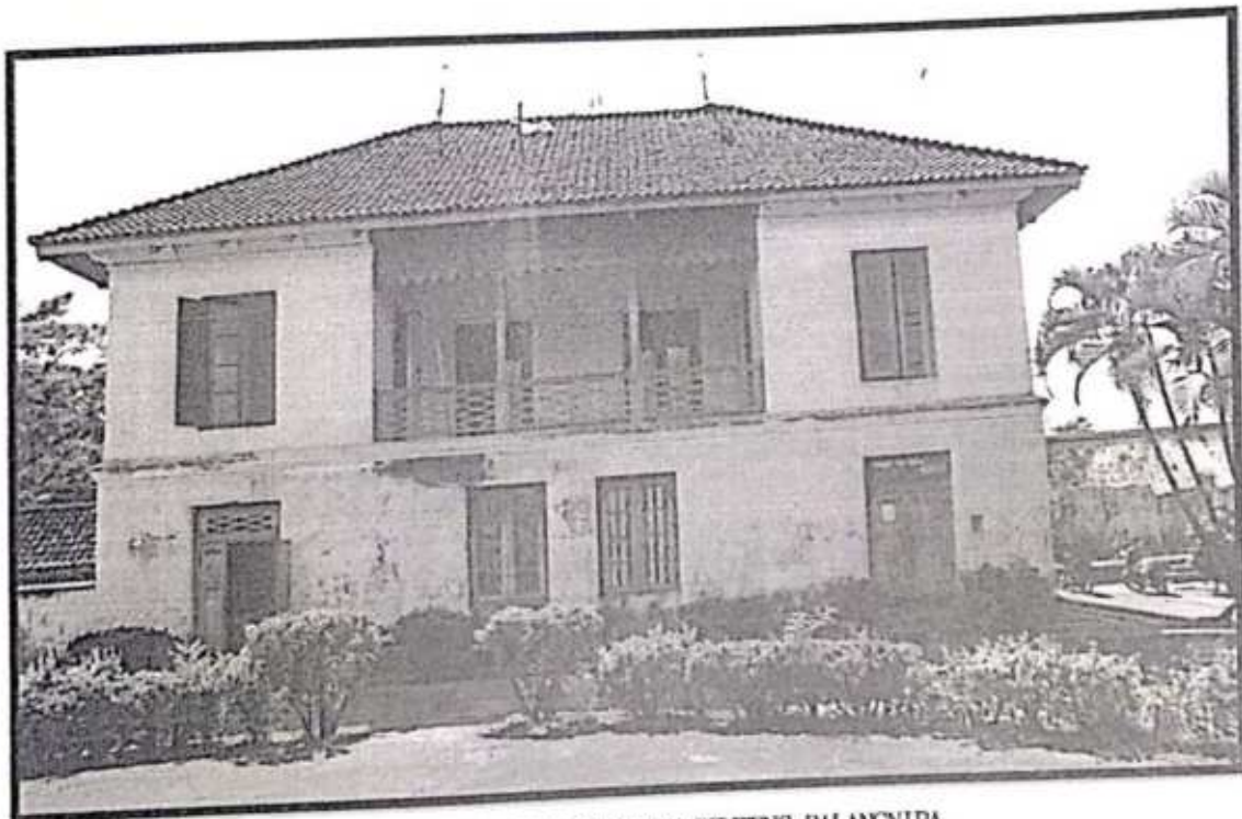
FOTO 8: BANGUNAN BARAK KOMANDAN BENTENG BALANGNIPA
