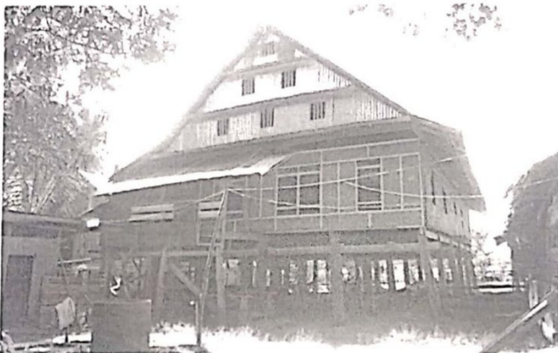
FOTO 2 : TAMPAK BELAKANG SAORAJA LINRUNG
